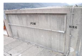
写真-1 RC 支柱式高欄
