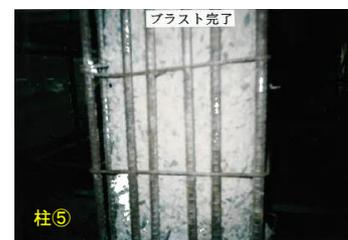
図-1 ラーメン橋脚-柱はつり状況（2003年）
