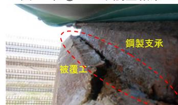
図-5 柱①被覆工の端部
