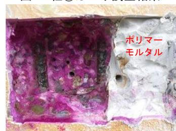
図-4 柱①はつり調査結果
