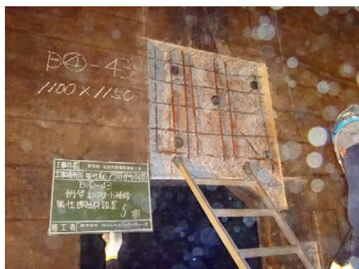
写真3 犠牲陽極材取付状況
