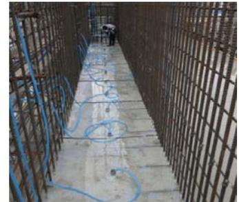
写真-1 鉛直パイプクーリング状況
