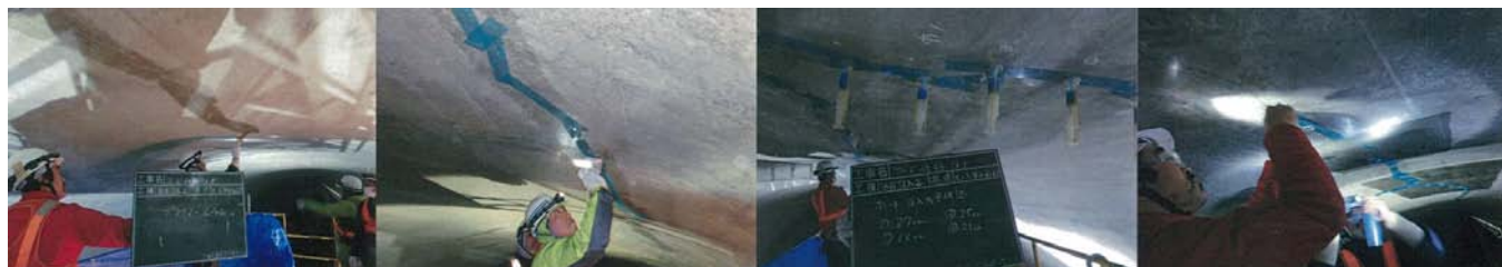
プライマー塗布
