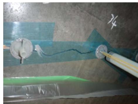
写真-2 注入時の確認状況
