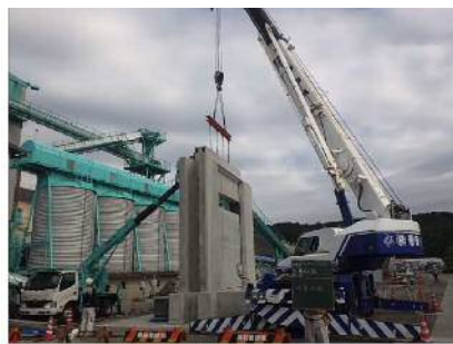
写真-5 遮水版の施工状況
