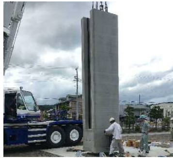
写真-2 柱の設置
