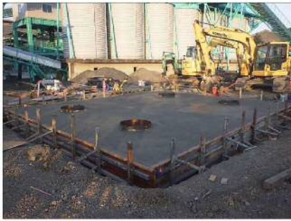
写真-1 基礎コンクリート打設状況
