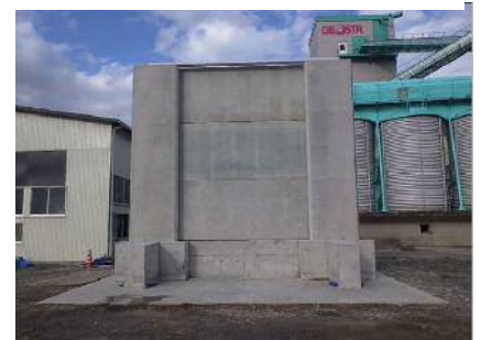
写真-6 完成状況
