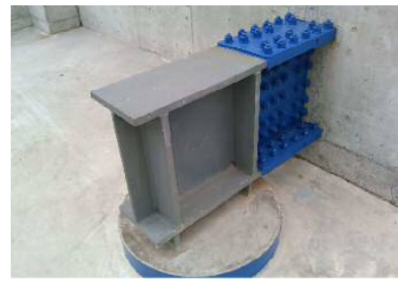
写真-3 フーチング鋼材ボルト連結
