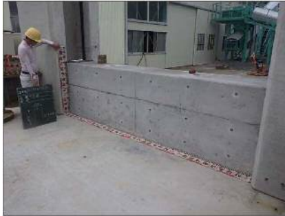
写真-4 地中梁の施工状況
