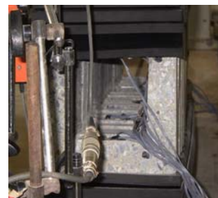
写真-2 変状発生状況
