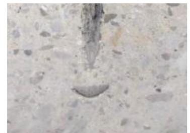
写真-2 拡径鉄筋定着状況
