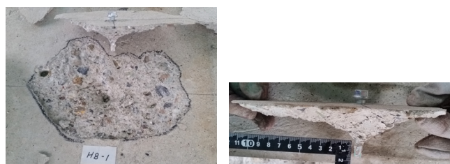
図-6 破壊状況 (H8-1)
