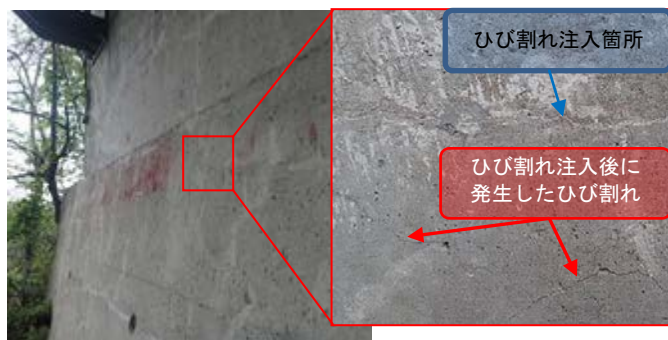
写真-2 ASR劣化橋台の補修後の状況（B橋）
