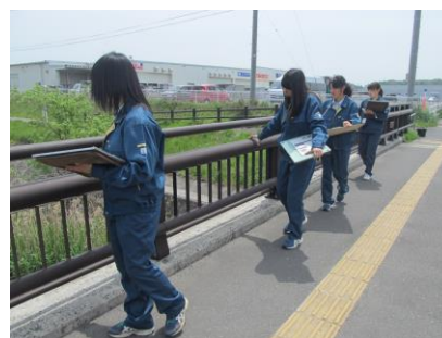
図-2 点検の様子
