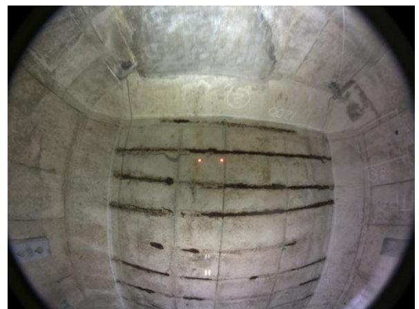
図 2 大型マンホールの上床版撮影画像
