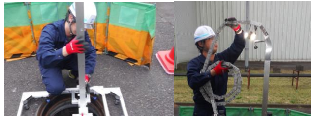
図 5 点検作業の様子
