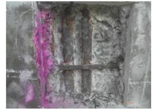
写真2 橋脚①ひび割れ 写真3 梁④-⑤ひび割れ
