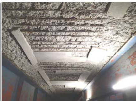
写真-3 脆弱部たたき落し後
