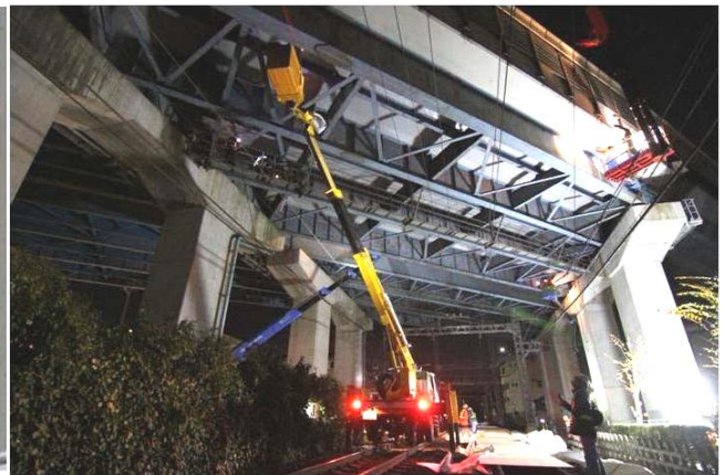
写真-2 平成26年12月の緊急たたき落とし点検
