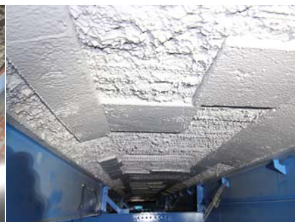
写真-4 塗布系材料による剥落対策
