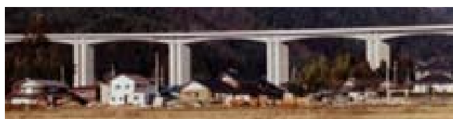
写真-2 中西高架橋 1)
