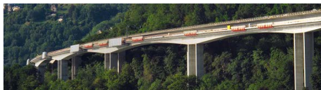
写真-1 chillion 高架橋 4)
