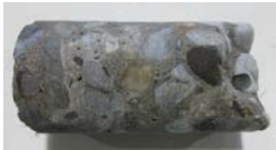
写真-4 大正供試体 No. 3 150 サイクル時の損傷状況
