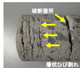
(a)側面の損傷状況
