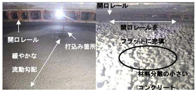
写真1 打込み状況 写真2 開口レール通過時
