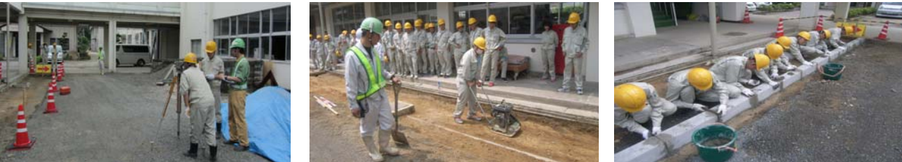
写真-1 準備工施工状況
