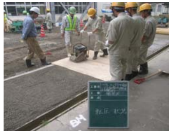
写真-4 初期転圧状況
