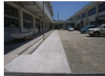
写真-5 完成状況
