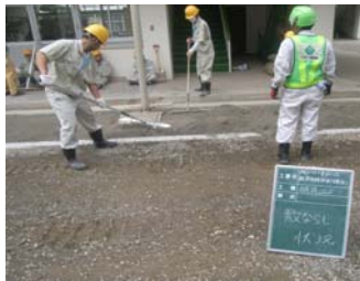
写真-3 敷き均し状況
