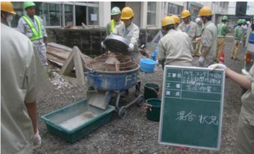
写真-2 再生コンの製造状況
