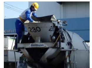
写真-2 アジテータ車への投入状況
