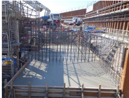
写真-2 BB80M20 仕上げ状況
