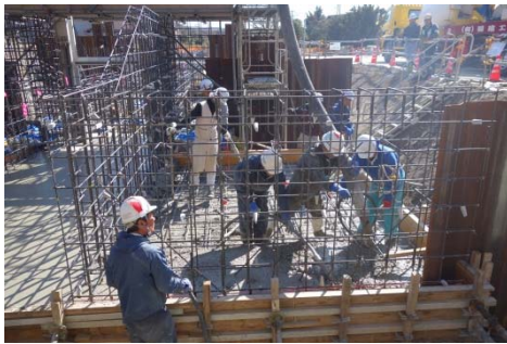
写真-1 BB80M20 打設状況
