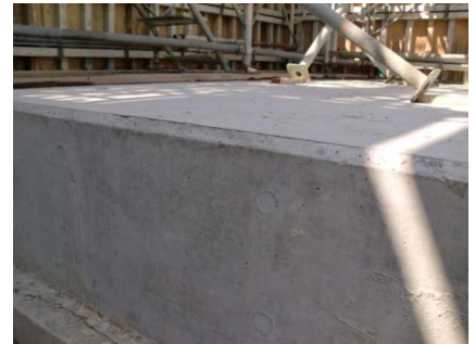
写真-3 BB80M20 脱型後の状況
