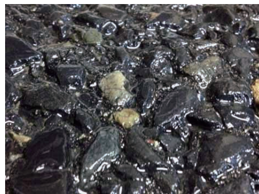
写真-1 路面の状況
