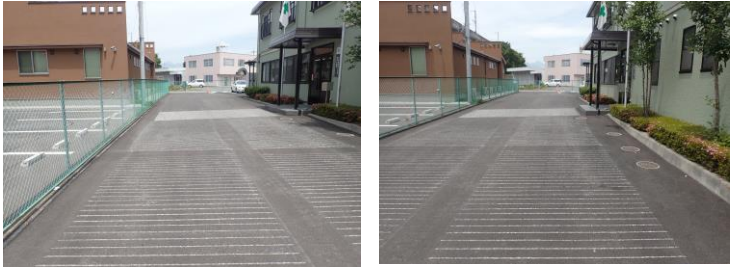
写真-4 同じ上幅 左:階段状 右:面取り
