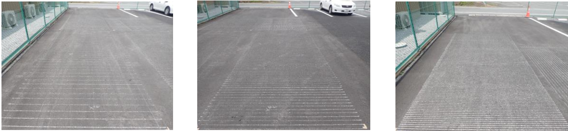
写真-3 削溝ピッチの影響：左から 120 mm (No.10)，60 mm (No.11)，30 mm (No.12)
