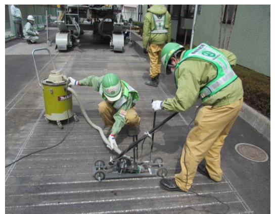
写真-2 削溝用面取マシン
