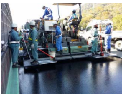
写真-1 実路施工状況
