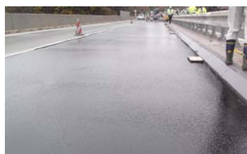
写真-4 レベリング層舗設面状況
