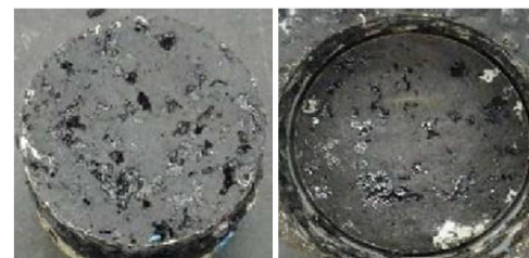
写真-6 供試体下面(左) 床版面(右)
