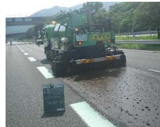
写真-1 浸透型クラックシール材注入状況 写真-2 浸透型補修材散布工施工状況
