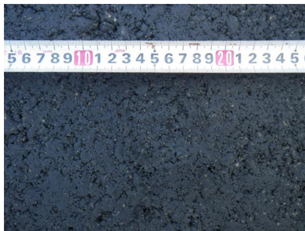
写真-2 仕上がり状況
