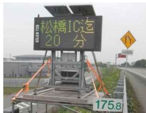
図2 仮設 LED による通過所要時間提供
