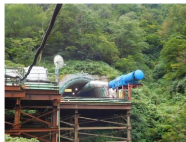
図-3 冠山峠道路第2トンネル工事現場(福井側坑口)
