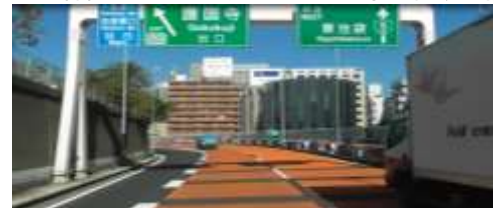
図-2 注意喚起カラー舗装の例 （首都高速5号池袋線下り護国寺カーブ）
