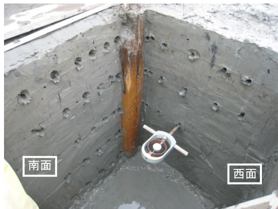
写真-2 水平方向のコーン貫入試験 (A11)
