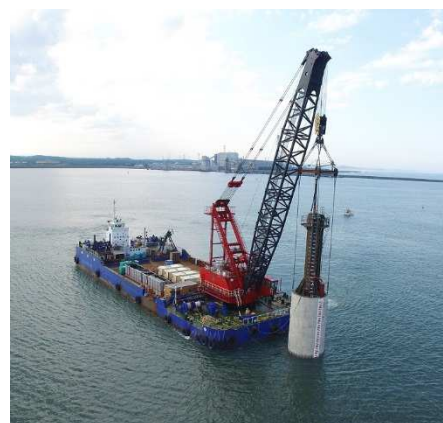
Photo 2 試験体吊曳航
