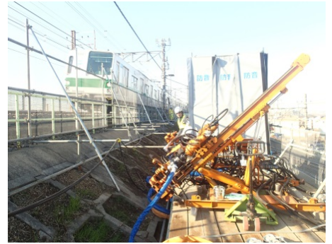
写真-1 小型削孔機による削孔状況
