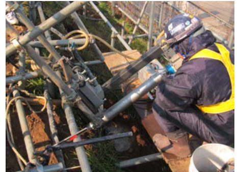
写真-2 コアドリルによる削孔状況
