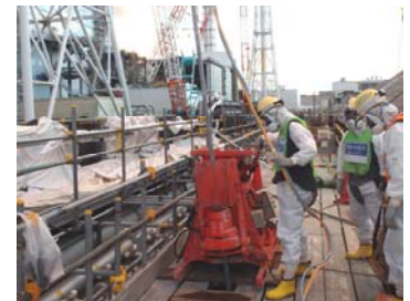
写真-2 薬液注入状況
