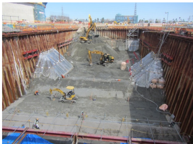
写真-1 掘削状況
