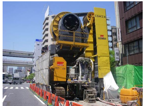
写真-1 クワトロカッター(昼間掘削状況)
