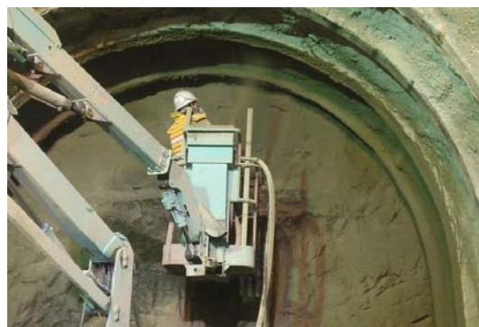
図-4 吹付け状況
