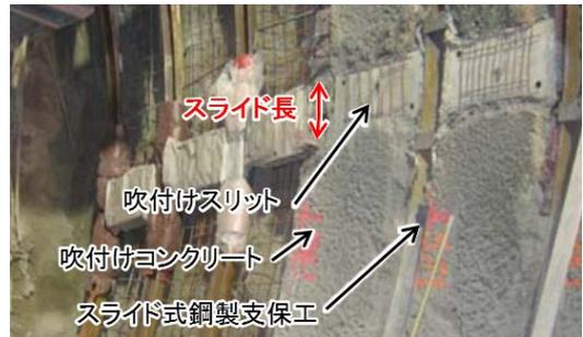
図-3 海外の変形制御型支保
