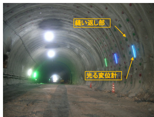
写真-2 変状部に光る変位計を設置した状況
