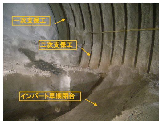
写真-1 二重支保工 施工状況 1)
