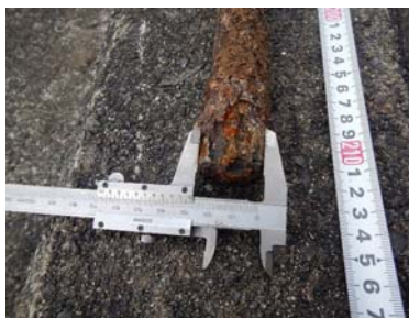
写真-1 破断面腐食状況
