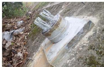
写真-5 くさび式アンカー
