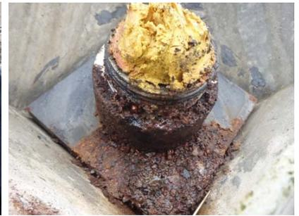
写真-4 定着具の錆・腐食
