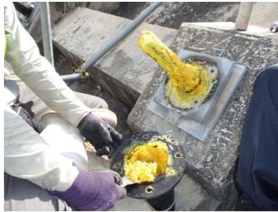
写真-3 防錆油の変色・劣化
