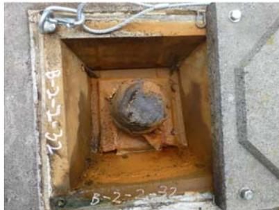
写真-7 雨水の浸入
