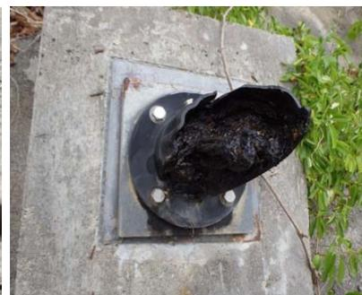
写真-2 頭部キャップの損傷
