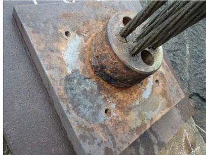
写真-5 定着具の錆・腐食
