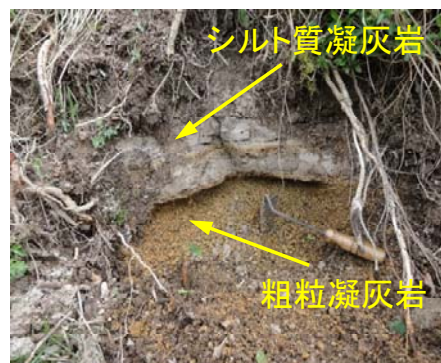
図-5 のり面の露頭状況
