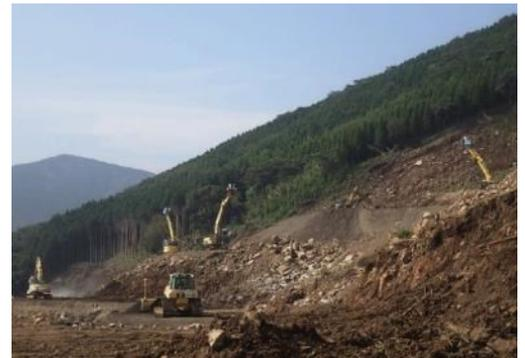
写真-1 無人化による施工状況
