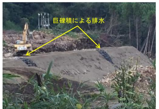
写真-2 巨礫積による排水の状況
