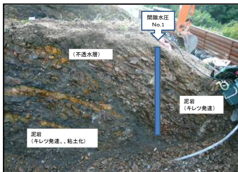
写真-4 Bのり面 間隙水圧計 No. 1 試掘状況
