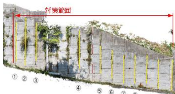
図-4 補強土壁の壁面変位調査箇所
