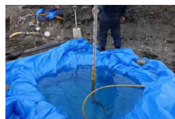
写真 2 現場密度試験/水置換状況
