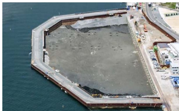
図-1 河川内の仮締切部(写真下方:流下側)
