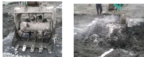
図-4 ミキシングバケット(左) と混合状況(右)
