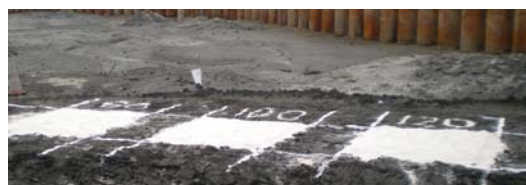
図-3 各区画への改良材の撒出し
