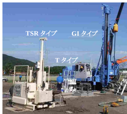
図-3 今回開発した施工機
