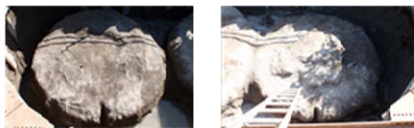
図-6 出来形確認状況(No.1, No.2)
